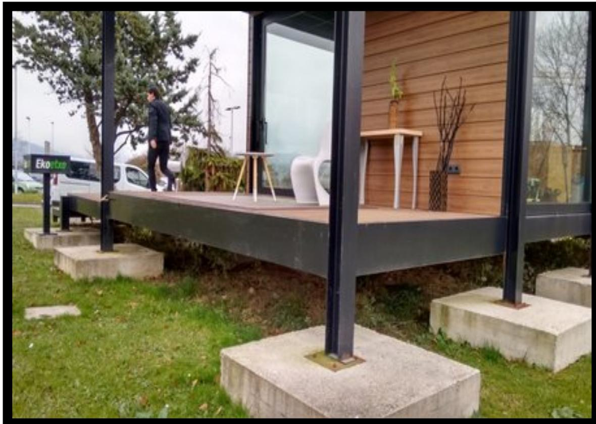
**AUSENCIA DE BARANDILLA EN PREFABRICADO EXTERIOR...**
